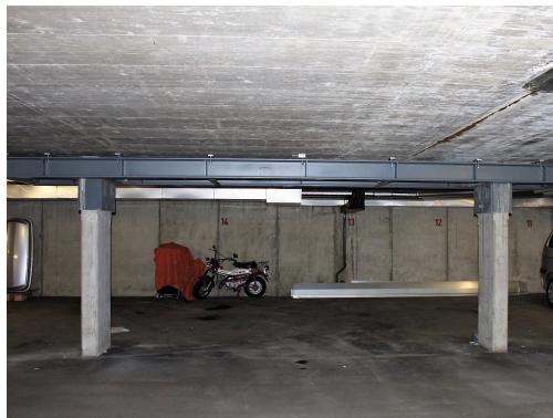
Träger als statische Verstärkung
