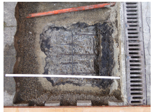
Sondage der vorhandenen Bewehrung
