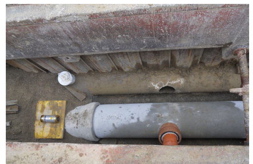
Arbeiten an den Werkleitungen
