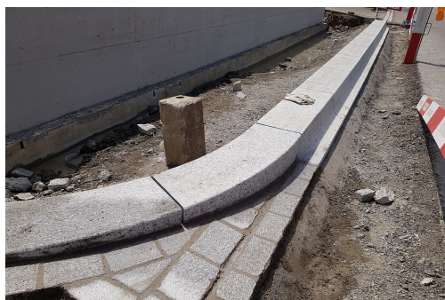
Neupflasterung der Randabschlüsse
