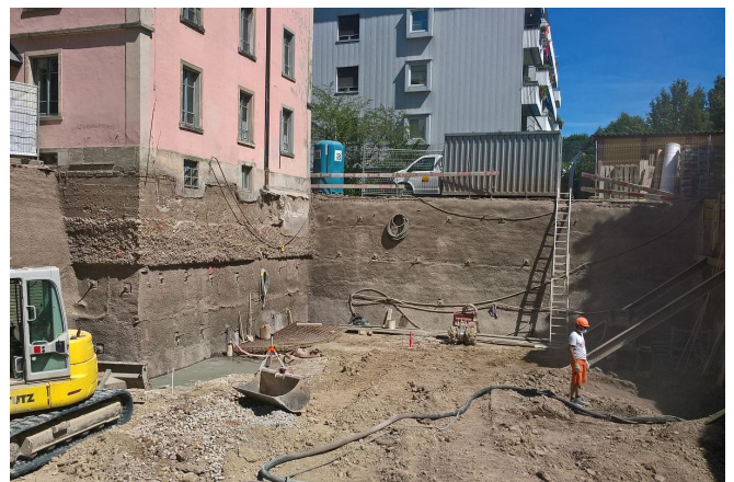
Nagelwand-und-Unterfangung
