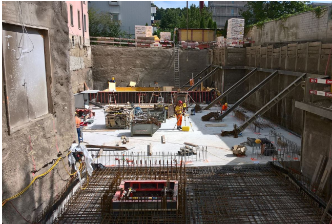
Ruehlwand-gespriesst-Ankerwand-Unterfangung-und-Bodenplatte
