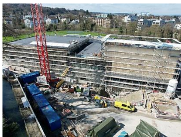
Neubau Hallenbad Frauenfeld
