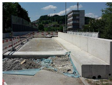
Erw.Murgbrücke Spange Hofen
