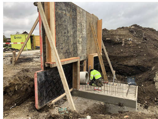
Schalung des neuen Einlaufbauwerks
