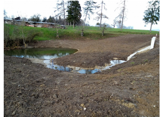
Neues Rückhaltebecken Rüsselbach
