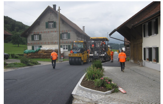
Einbau Tragschicht
