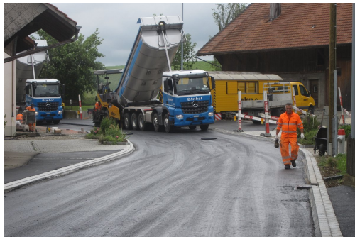
Einbau Tragschicht
