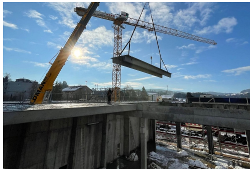
Versetzen SAW Elemente quer
