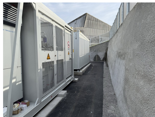
Permanente Nagelwand und Anlagecontainer
