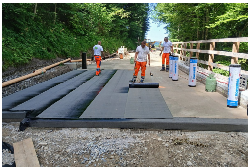
Abdichtungsarbeiten
